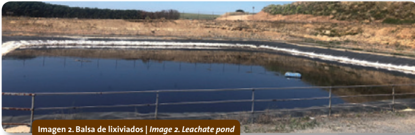
Imagen 2. Balsa de lixiviados | Image 2. Leachate pond
